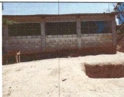
Foto 8: Pintura en muros exteriores e interiores
