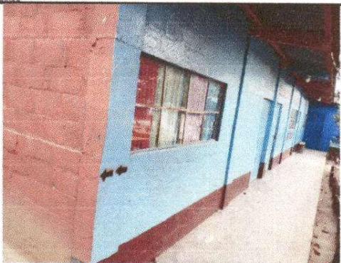
Foto 7: Pintura en muros exteriores e interiores
