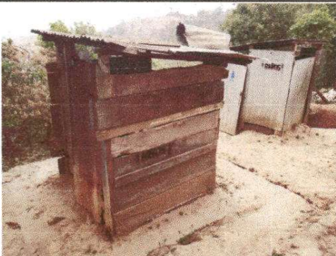
Foto 3: Sustrucción estructura, cubierta, letrina de baños
